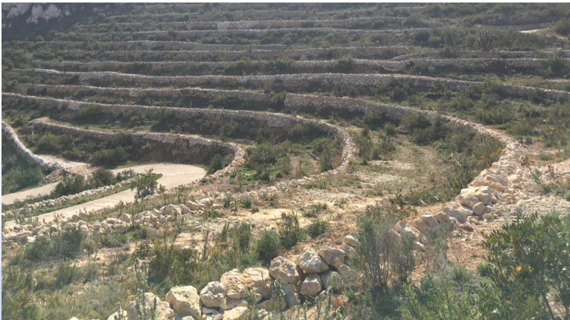
Muros de piedra seca restaurados en la ladera norte del Barranco de Martorell, junto a la cala Granadella. Fuente: Vicente Deltoro (18-2-2021).
