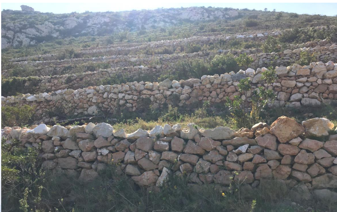
Restauración de muros de piedra seca en la ladera norte del Barranco de Martorell, junto a la cala Granadella. Obsérvese los procesos erosivos de intensidad moderada existentes antes de la actuación (arriba). Fuente: Ramón García Pereira (11-9-2018) y Vicente Deltoro (18-2-2021).
