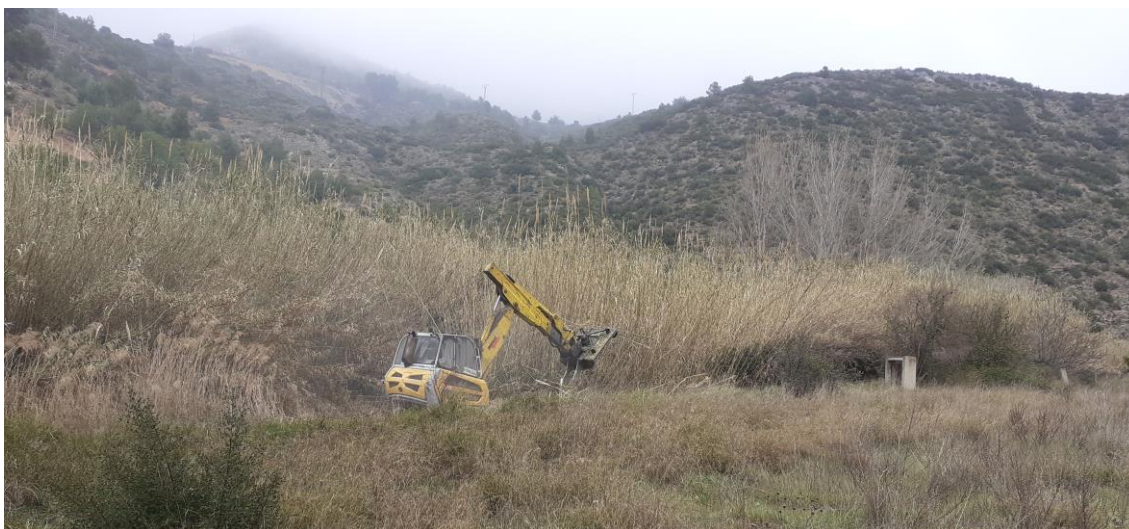
Desbroce de cañaverales con retroaraña en las orillas del río Reatillo (Sot de Chera). Fotografía: FORESA (18-02-2020).
