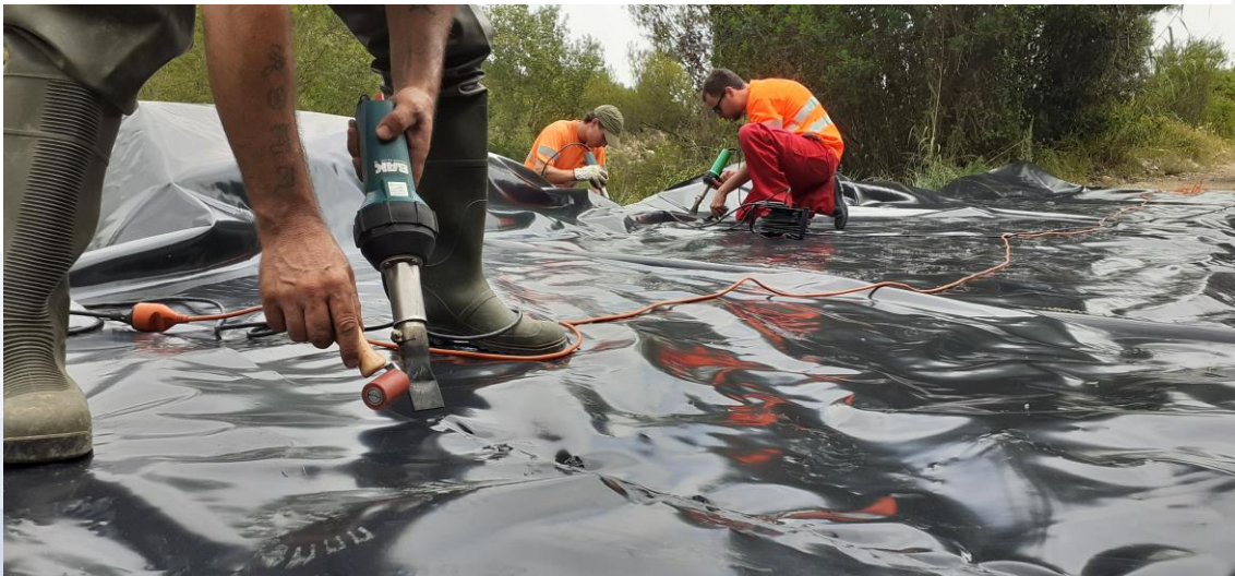
Termosellado en las zonas de solape durante la colocación de coberturas opacas en el río Reatillo. Fotografía: FORESA.
