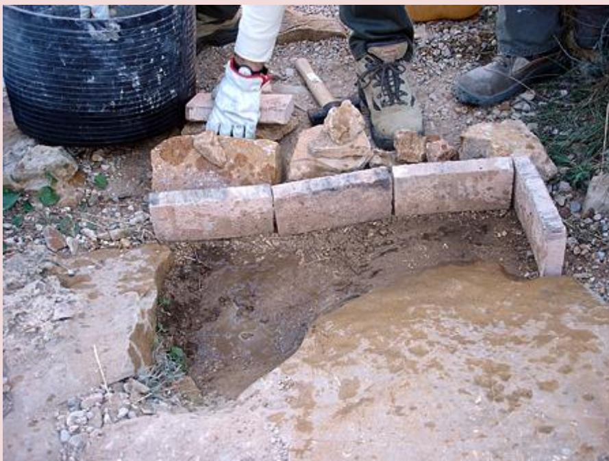
Fotografía: Construcción de escalones en la Punta Cavall, Benidorm Fuente: Archivo fotográfico del Parc Natural de la Serra Gelada
