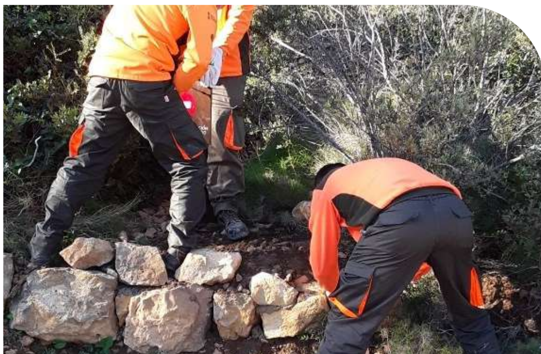
Imagen: construcción de un pequeño muro de mampostería en piedra seca y posterior plantación de alguna sspp forestal con el fin de eliminar sendas secundarias en el PN.
