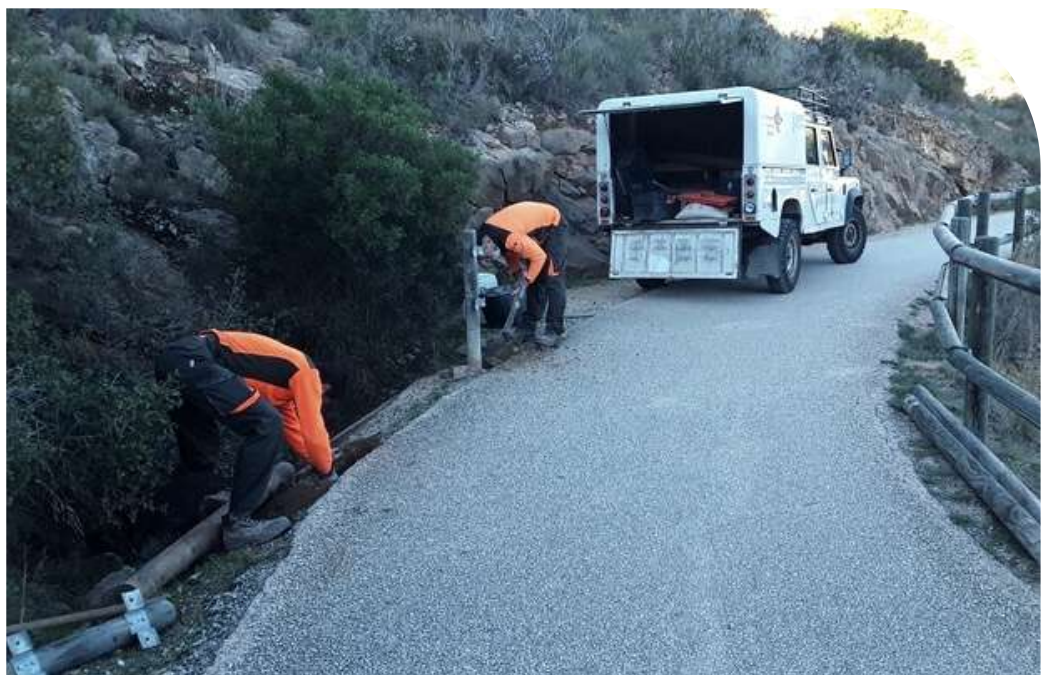
Imagen de la sustitución de rollizos delimitadores en el itinerario del faro de l'Albir.
