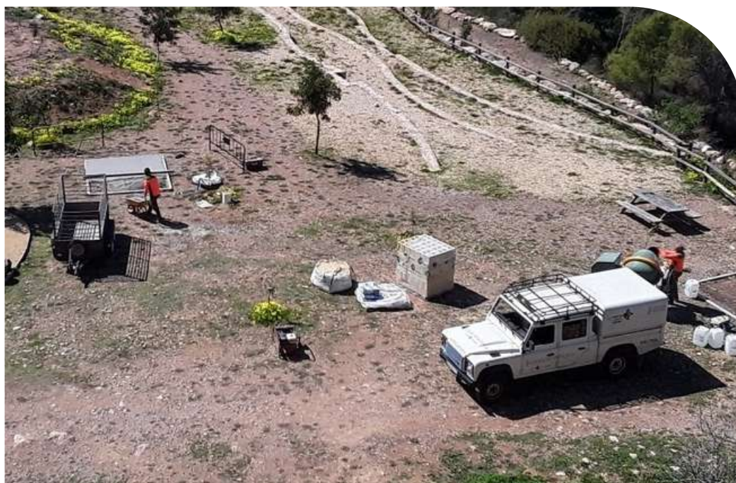
Imagen de trabajos de mejora de los equipamientos de uso público en la cantera de l'Albir.
