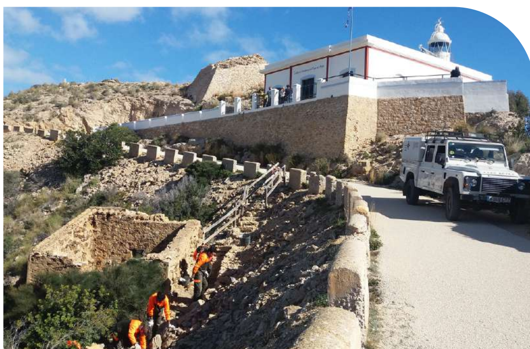
Imagen de trabajos de mantenimiento de la senda de acceso al aljibe del faro de l'Albir - ruta roja del PN.
