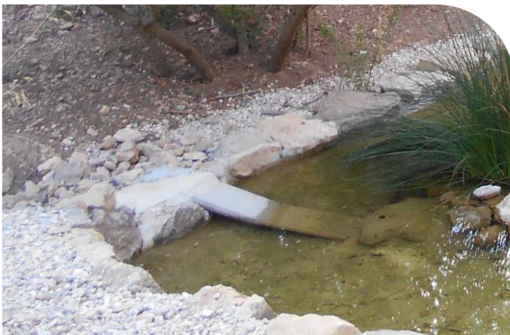
Imagen: Detalle constructivo de la charca para anfibios acondicionada por el ECM aprovechando el agua sobrante de la fuente pública situada junto al merendero de la ruta roja del PN.
