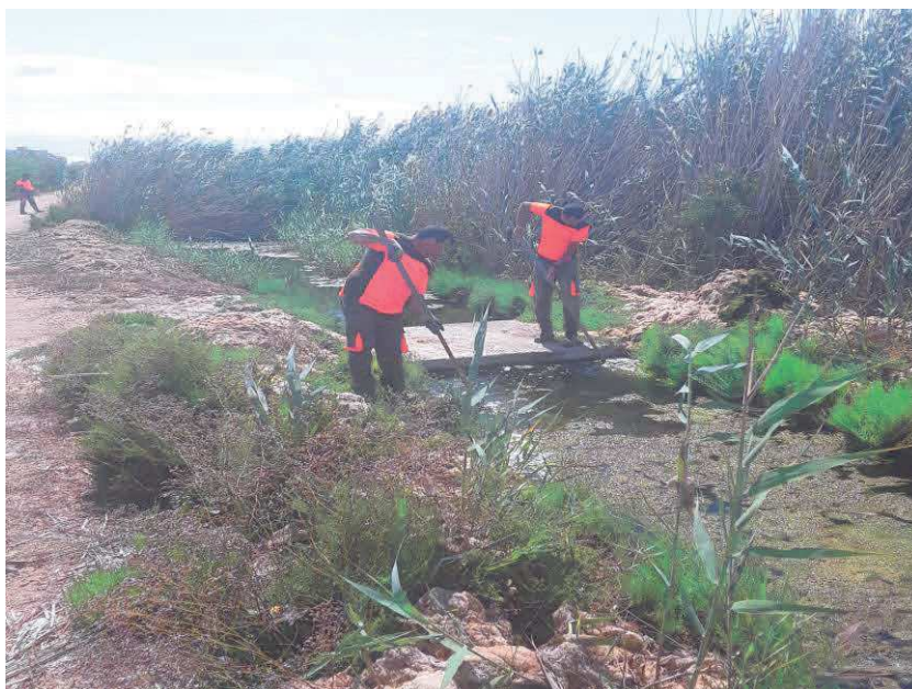
ILUSTRACIÓN 16: ACTUACIÓN DE ACONDICIONAMIENTO DE SURGENCIAS DE AGUA
