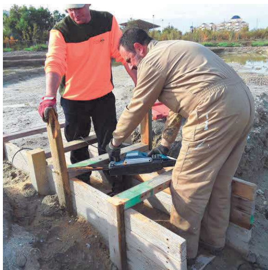
ILUSTRACIÓN 18: ACTUACIÓN DE ADECUACIÓN DE ÁREAS DE USO PÚBLICO
