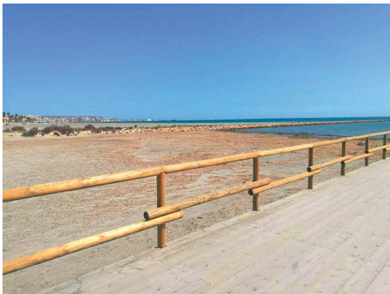
ILUSTRACIÓN 59: SUSTITUCIÓN DE LOS PASAMANOS EN MAL ESTADO DEL MUELLE
