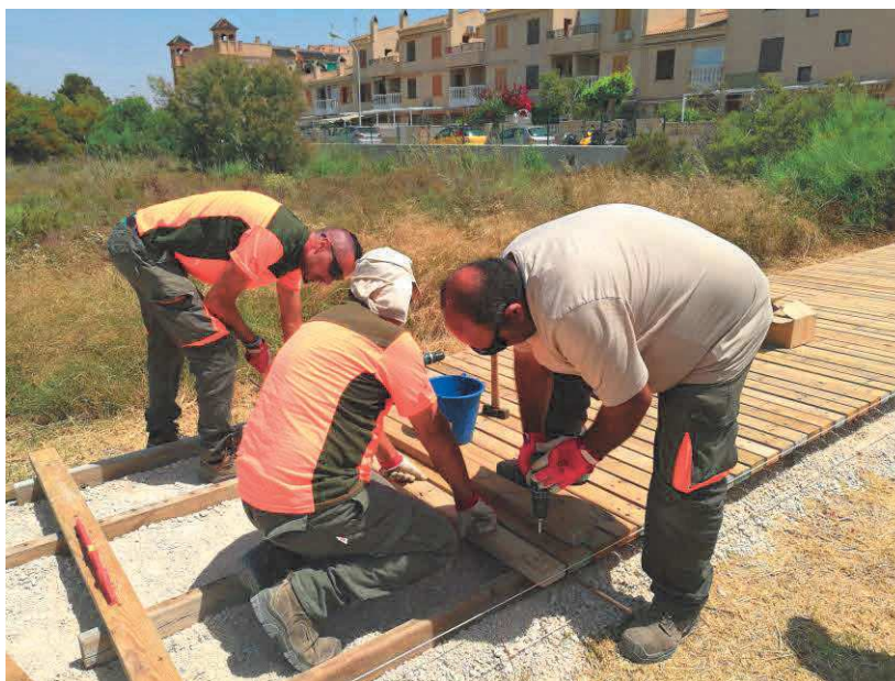
ILUSTRACIÓN 19: ACTUACIÓN DE ADECUACIÓN DE INFRAESTRUCTURAS E INSTALACIONES
