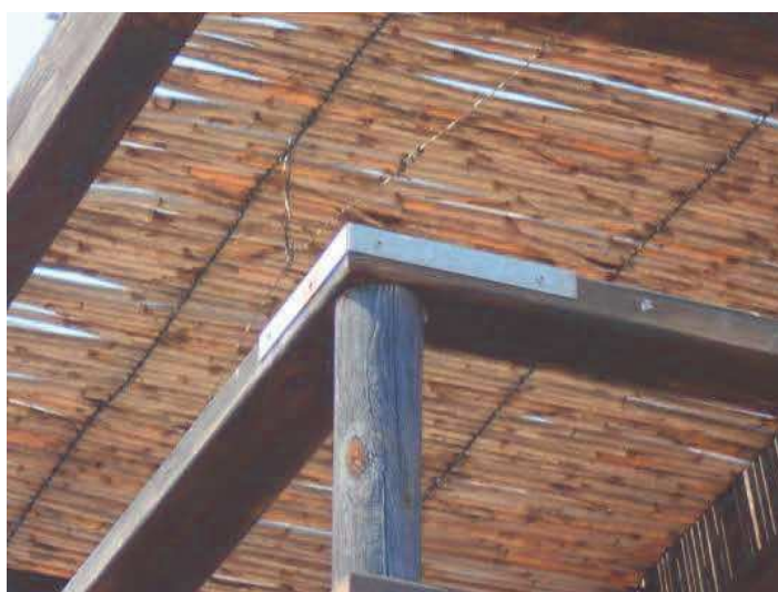
ILUSTRACIÓN 58: REFORZAMIENTO PARTE SUPERIOR DE LA TORRE EL ALTILLO
