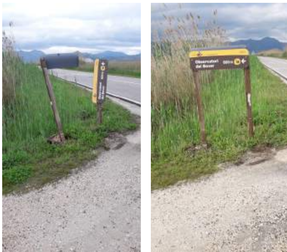
Figura 7-1: Senyal direccional arreglada per la Brigada de Manteniment.
