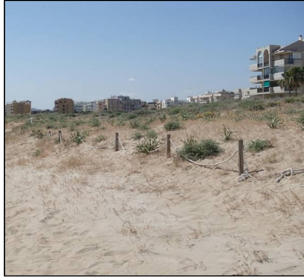
Figura 8. Izquierda: trabajos de rehabilitación en talanqueras rotas y caídas en la playa de Tavernes de la Valldigna. Derecha: talanqueras colapsadas en la playa de Daimuz que han perdido su funcionalidad.
