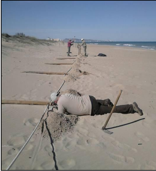
Figura 8. Izquierda: trabajos de rehabilitación en talanqueras rotas y caídas en la playa de Tavernes de la Valldigna. Derecha: talanqueras colapsadas en la playa de Daimuz que han perdido su funcionalidad.
