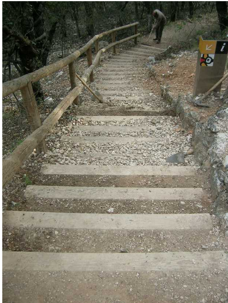
Millora del traçat i paviment de l'escalera de la senda del Menejador
