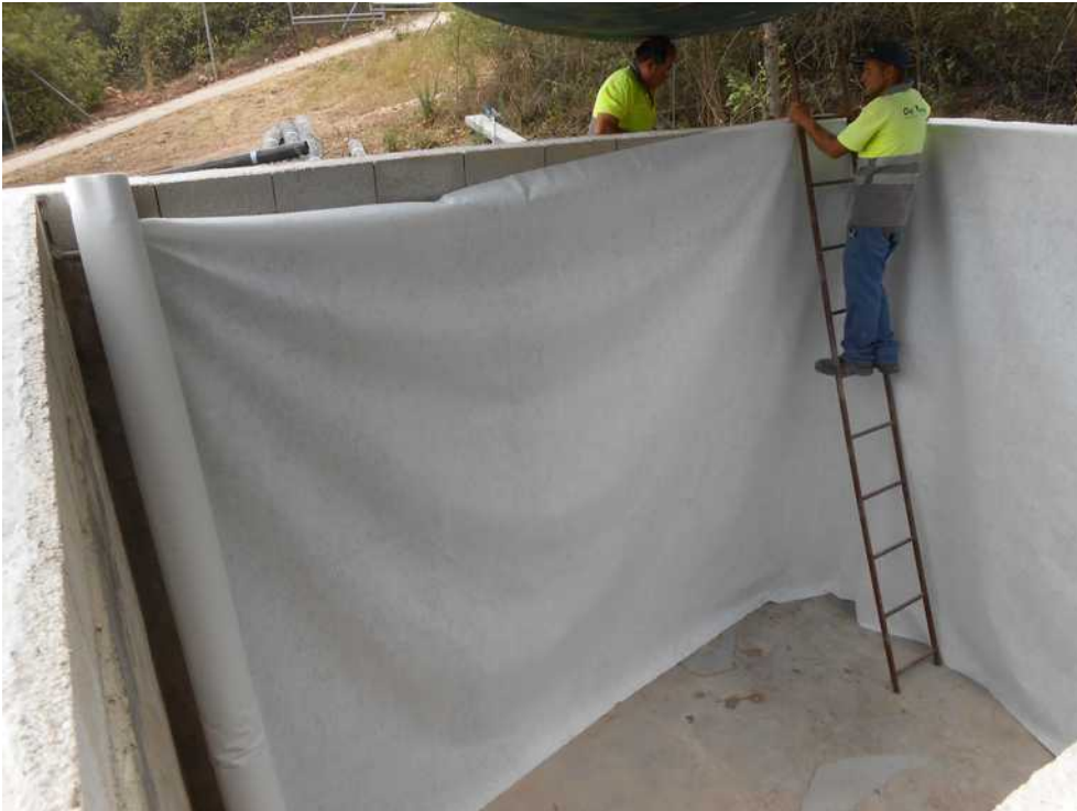
Treballs de millora i revestiment de la bassa del viver per a emmagatzemar les aigües sobrants de la depuradora
