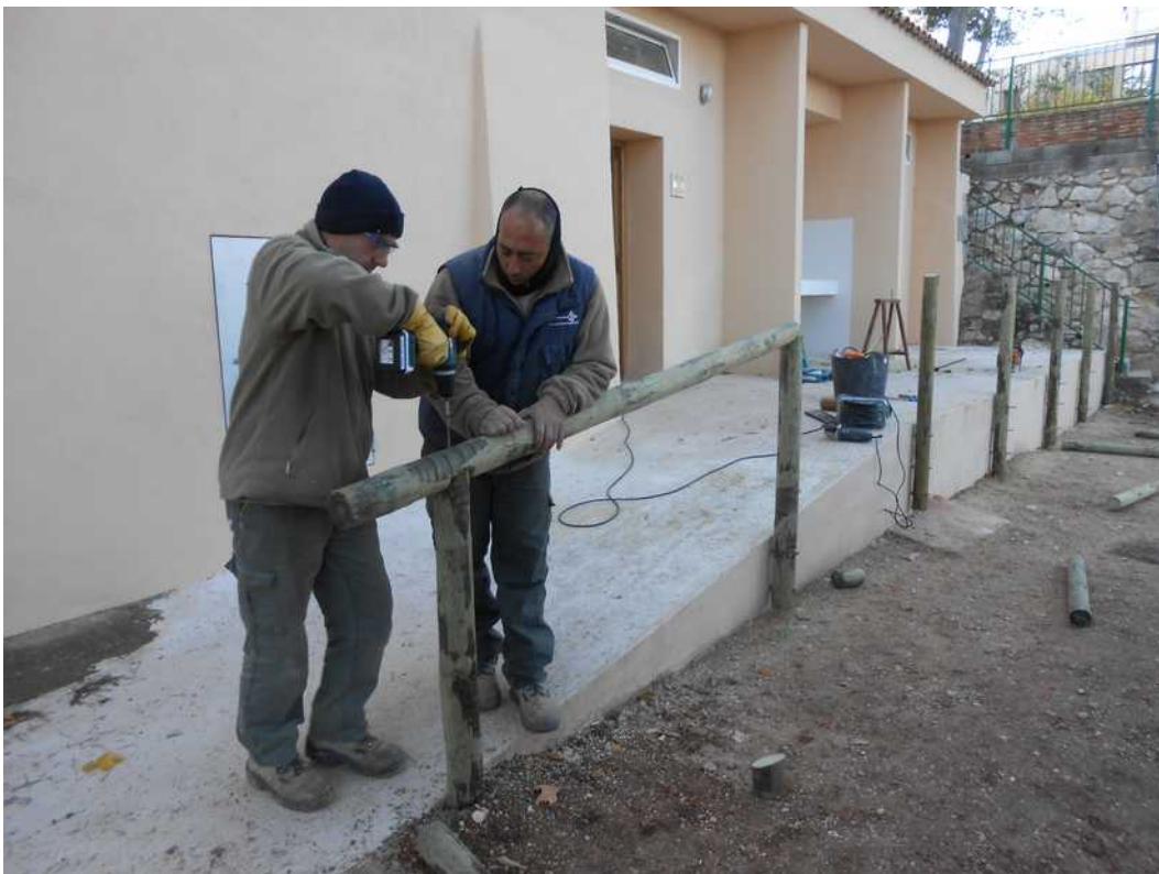
Treballs de col·locació de la barana dels nous vestuaris de la Font Roja
