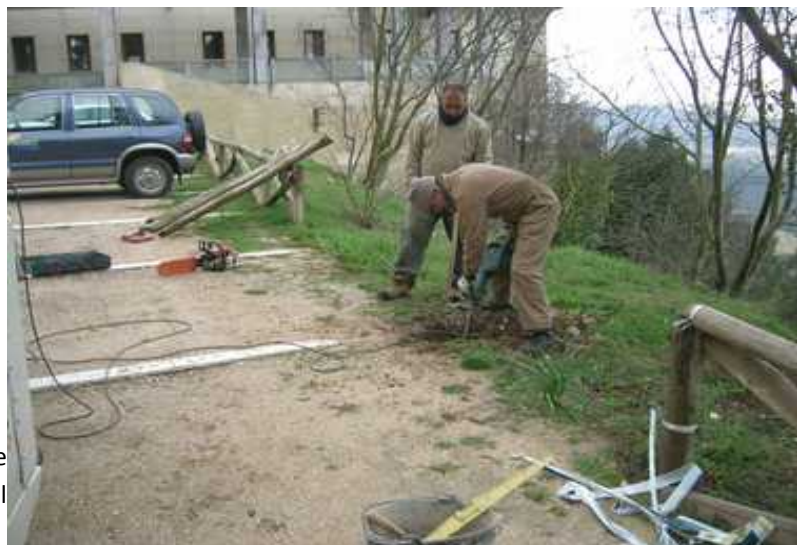
Reparació de la barana de fusta en el àrea del aparcament
