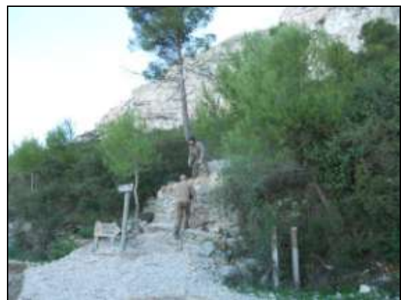
Desprendimiento de un runar al Camí de Colònia
