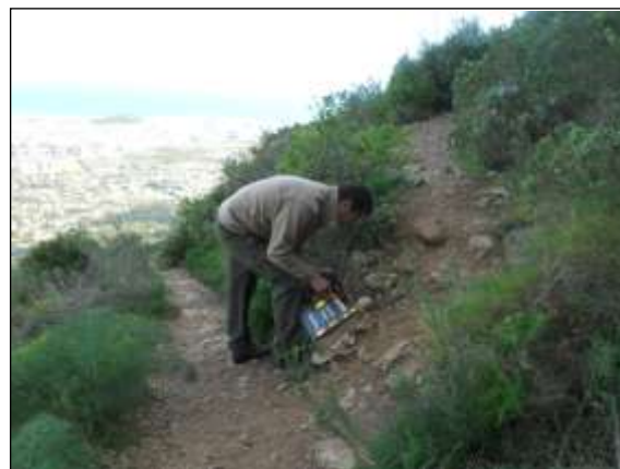
Trabajos de reparación de señalética en la ruta del Racó del Bou
