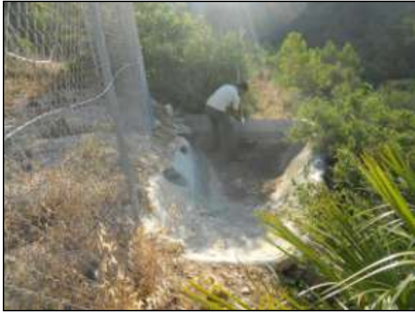
Figura 16: Mantenimiento de la balsa del Camí del Repetidor
