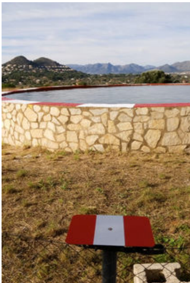
Figura 3: Dipòsit d'aigua amb millora de visibilitat
