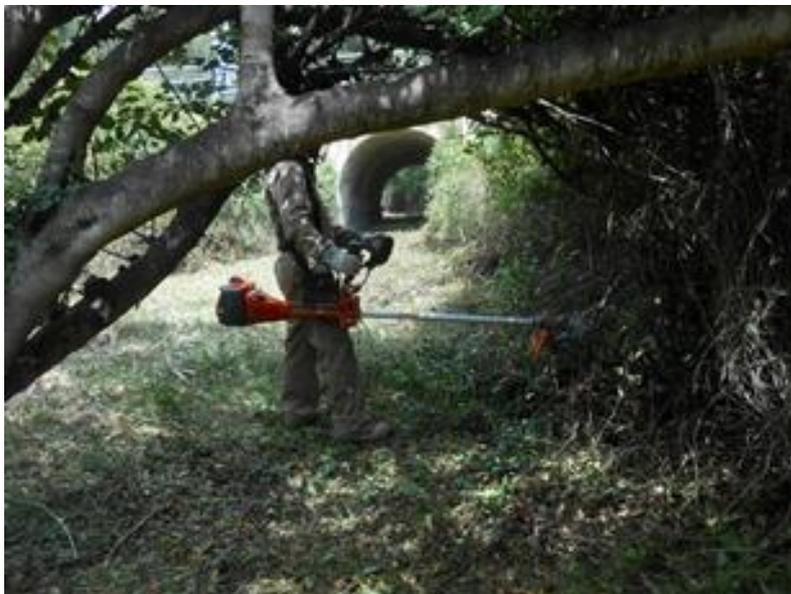
**Figura 14:** Detalle de los trabajos de permeabilización de los pasos de fauna
