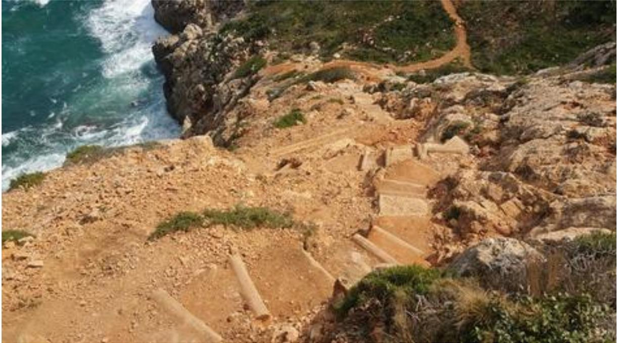
**Figura 23:** Escalones en muy mal estado en la Cova Tallada.
