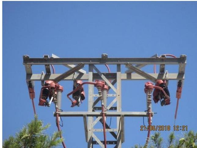
**Foto 5.** Poste elèctric modificado con elementos aisladores
