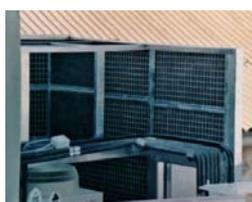
**TL-TU-58. Cápsulas.** El encapsulado es una solución similar al apantallamiento, con la diferencia de que en este caso se aislaría el emisor sonoro del exterior mediante una envolvente, cubierta o introduciéndolo en una habitación.
