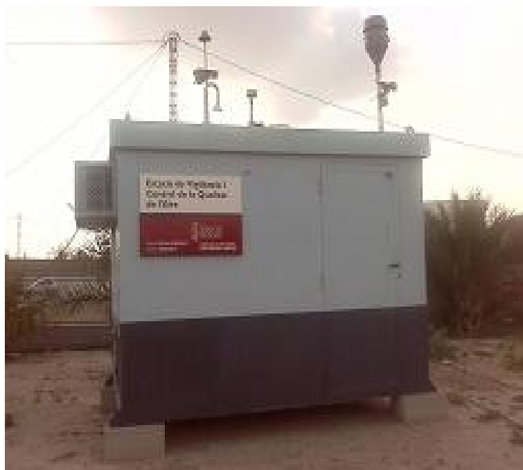
Foto: Estación de ELX-PARC DE BOMBERS
