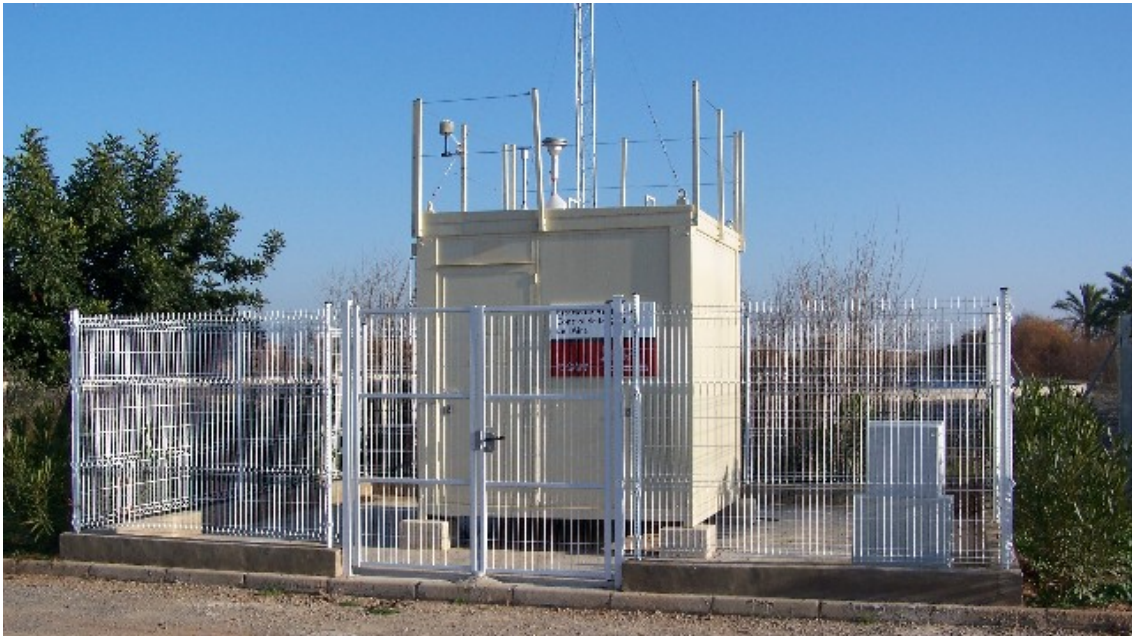
Foto: Estación de SAGUNT-CEA
