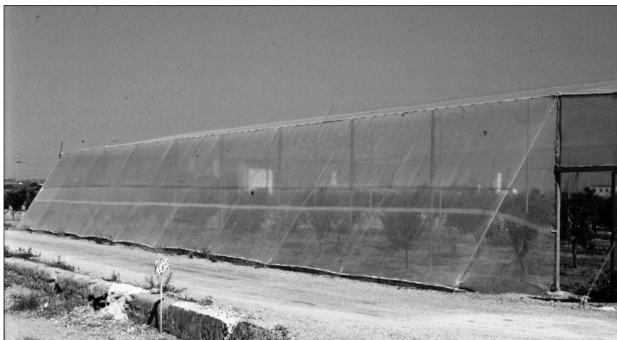
7.9 Cubierta de malla fija, instalada para comprobar el comportamiento de dos variedades de clementino, en condiciones de luminosidad restringida y al abrigo de algunos accidentes meteorológicos como el viento y el granizo. A la izquierda de la imagen se encuentra la parcela testigo sin cubrir. (Foto cedida por I. Trénor).
