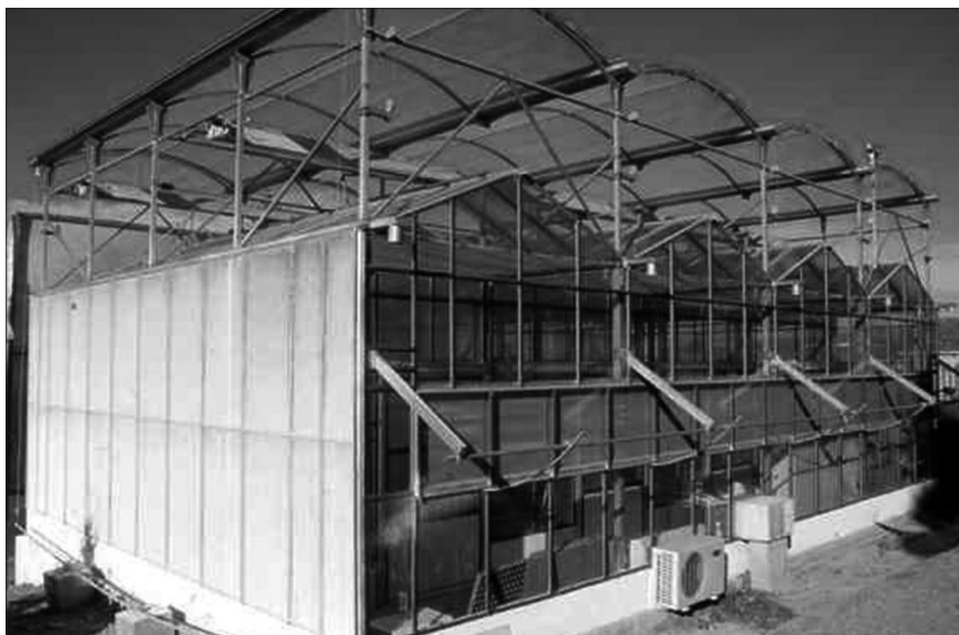
7.17 Invernadero entomología dotado de cabinas independientes, en las que se puede controlar las condiciones de desarrollo de los insectos: iluminación, temperatura y humedad. (Foto del autor).
