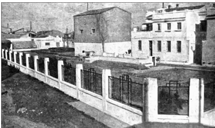
5.20 Conjunto de la Estación Arrocerera hacia 1951. (J.M. Carrasco. Compendio arrocerero . 1952).
