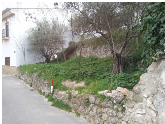
Vista de las parcelas afectadas por el trazado del vial antes de las obras
