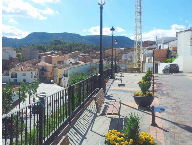
Vista de la urbanización del espacio libre viario en la Calle Guillén
