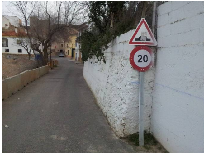
Vista de los estrechamientos del camino antes de las obras
