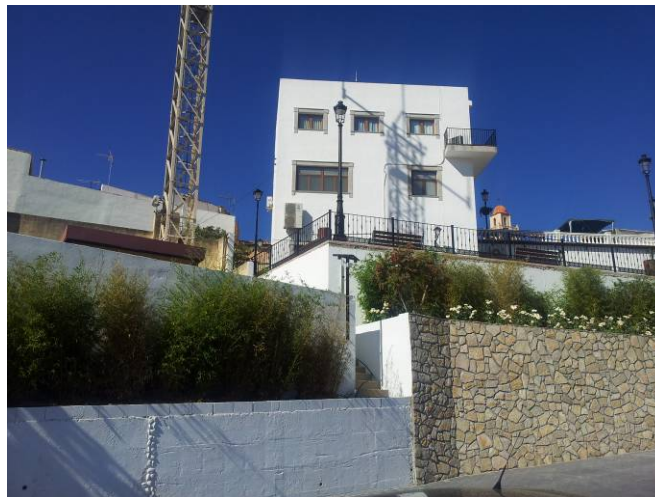
Diferencia de cota entre calle Carretera de Circunvalación y Guillén
